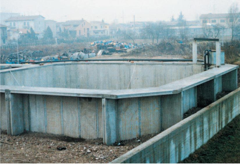
*Fig.1.3 Las placas huecas para un depósito en una depuradora de aguas*
