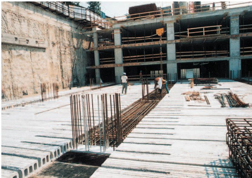
*Fig.1.2 Las losas huecas en un aparcamiento subterráneo de varios pisos*
