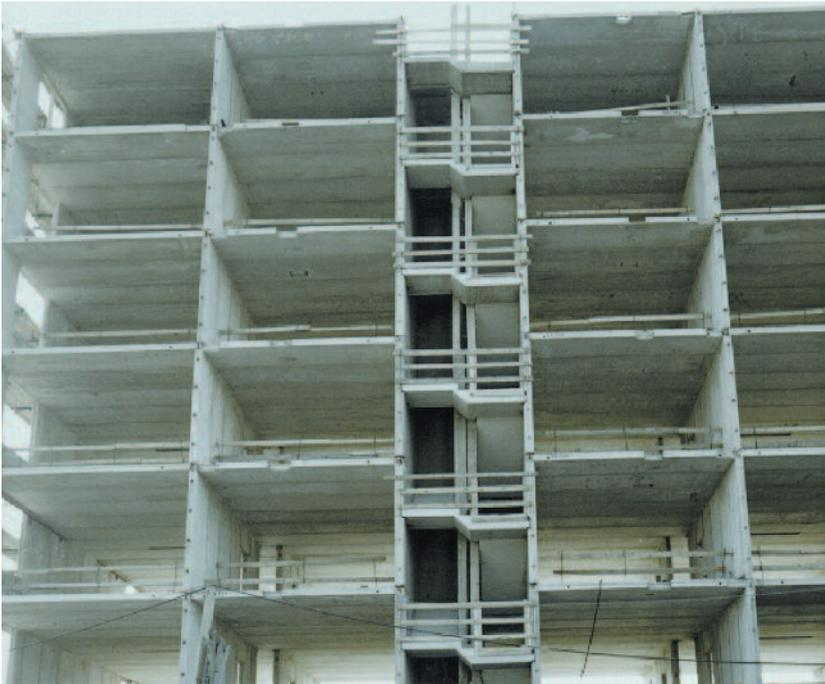
*Fig.1.4 Las placas huecas portantes y los forjados huecos en un edificio de viviendas de varios pisos.*
