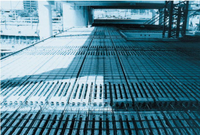
Fig. 4.16 Extremos de las losas preparados para el vertido de un ala colaborante de bastante extensión.
