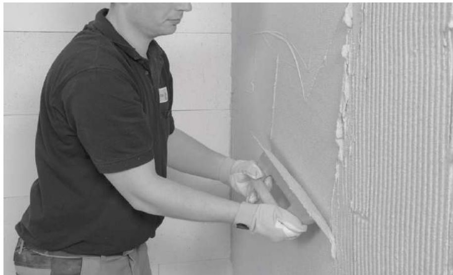
Esecuzione della rasatura armata
