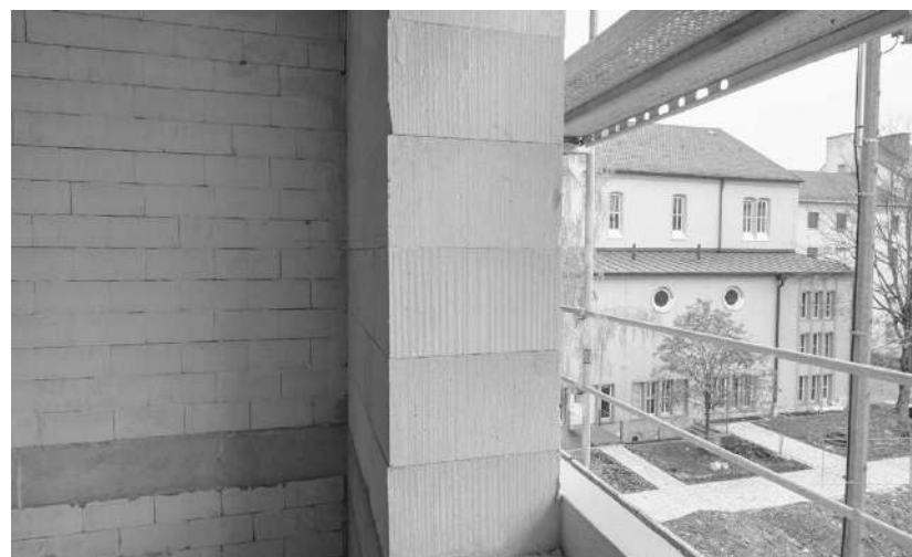
Particolare apertura su muratura di tamponamento
