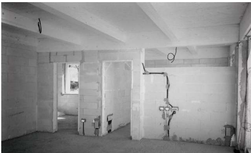
Esecuzione di tracce impiantistiche nelle tramezze
