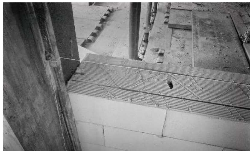
Rinforzo della muratura in tralicci di acciaio inseriti nei corsi di malta
