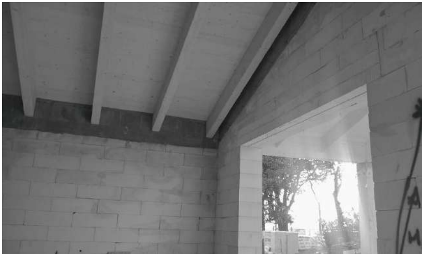
Ancoraggio copertura in legno lamellare su muratura
