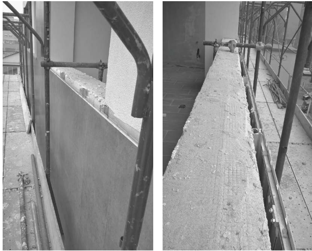
Fissaggio della facciata ventilata su muratura in AAC
