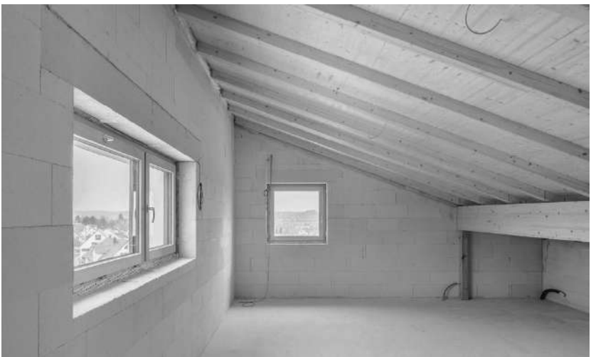
Ancoraggio copertura in legno lamellare su muratura
