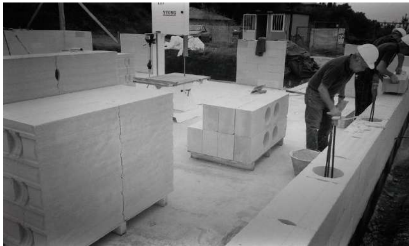
Utilizzo di blocchi forati per la realizzazione di elementi di irrigidimento in c.a.
