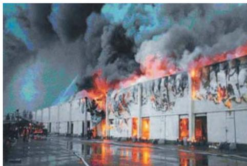
Fig. CS8.1 I pannelli sandwich in metallo leggero non sono riusciti ad impedire che il mattatoio di Bordeaux (Francia) andasse distrutto nel devastante incendio del gennaio 1997. Le fiamme avvolsero tutto l'edificio e si estesero anche agli immobili adiacenti (per gentile concessione di SDIS 33, Fire and Rescue Service, Gironde, Francia).
