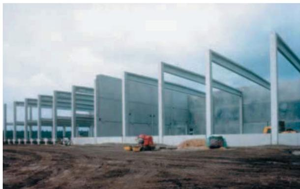
**Fig. 2.3** Pareti prefabbricate dotano questo magazzino di una compartimentazione ignifuga. (per gentile concessione di BDV, Germania).
