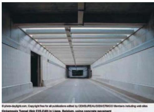
Fig. CS5.2 Le superfici stradali realizzate in calcestruzzo resistono alle condizioni estreme di temperatura che si sviluppano, in caso d'incendio, all'interno delle gallerie.
