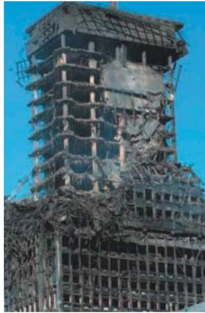
Fig. CS3.1 La facciata al di sopra del piano tecnico, il 16°, è completamente distrutta. Torre Windsor, Madrid (per gentile concessione di IECA, Spagna).
