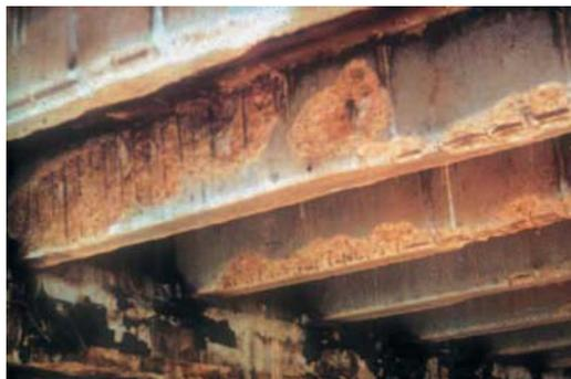
**Fig. CS1.2** Esempi di spalling negli elementi di calcestruzzo dopo l'incendio (per gentile concessione di DBV, Germania).
