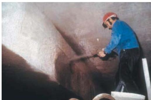
**Fig. CS1.3** Riparazione degli elementi con calcestruzzo spruzzato (per gentile concessione di DBV, Germania).
