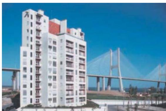
**Fig. 5d** Torre Verde, un edificio residenziale "verde" di 12 piani (7.200 m<sup>2</sup>), costruito in calcestruzzo a Lisbona, Portogallo. Dalle analisi è emerso che rispetto ad un edificio convenzionale il volume annuo delle emissioni di CO<sub>2</sub> è più basso di 24 t. I pannelli solari forniscono il 70% dell'energia necessaria per i consumi domestici di acqua calda degli inquilini (per gentile concessione di Tirone Nunes, SA, Portogallo).
