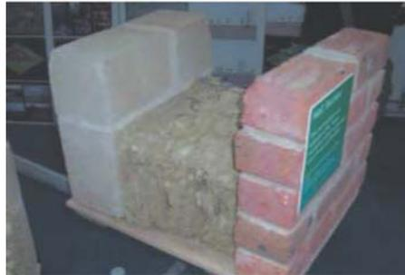
**Fig. 2d** Sezione di una parete esterna altamente isolata con strato interno di calcestruzzo pesante. La massa termica assicura un rendimento termico eccellente in tutte le stagioni combinando il maniera ottimale il flusso e l'assorbimento dell'energia (*BedZED, GB*).
